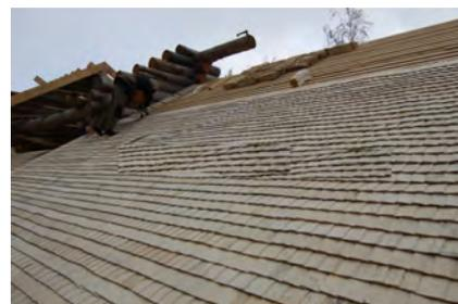
Для изготовления деревянной (черепицы) используют отборную, высококачественную древесину. Таковую, которая обладает зрелым возрастом, плотными годовыми кольцами, что является показателем высокой прочности дерева.
